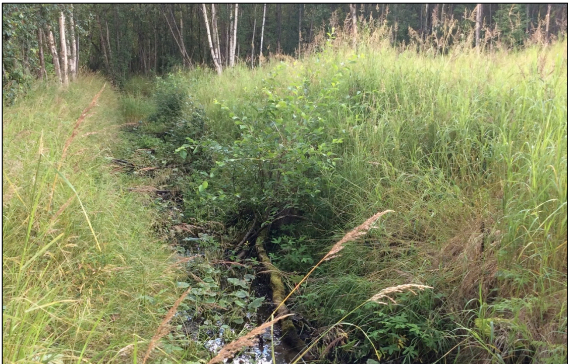
Dreneringsgrøft ved Monsbakken i Alta kommune. Foto: Gunn-Anne Sommersel.
